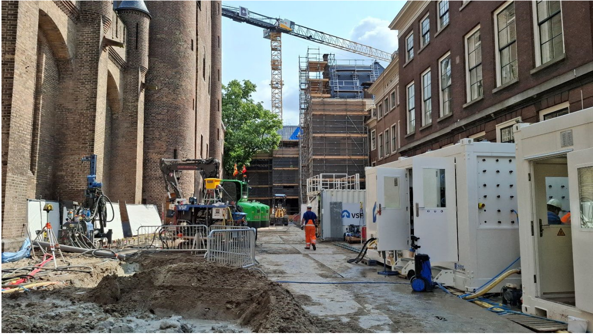
(Afbeelding 10: funderingsversterkingen Grafelijke Zalen)
