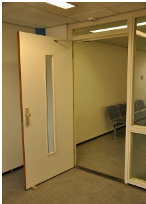
Voorbeelden van vastgezette deuren in brandwerende scheidingen.
