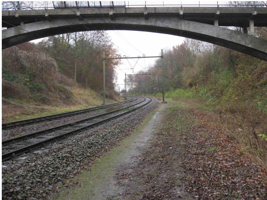
Afbeelding 3: De situatie zoals op de lijn Heerlen – Maastricht. De spoorlijn ligt verdiept en de omgeving van het spoor is bosrijk. Als gevolg van het platrijden van de vele herfstbladeren die zich verzamelen in en rond het spoor ontstaat een vetachtige substantie op de spoorstaven.
