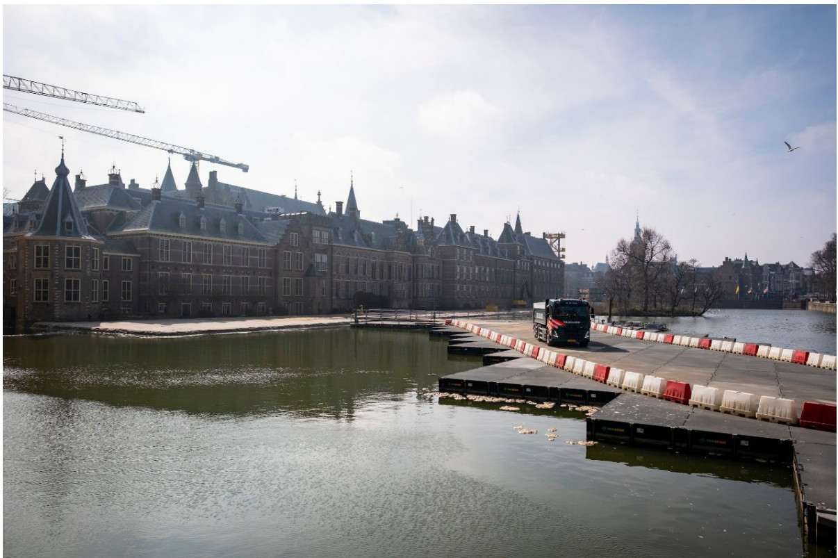
Opbouw werkterrein Hofvijver. David van Dam / de Volkskrant
