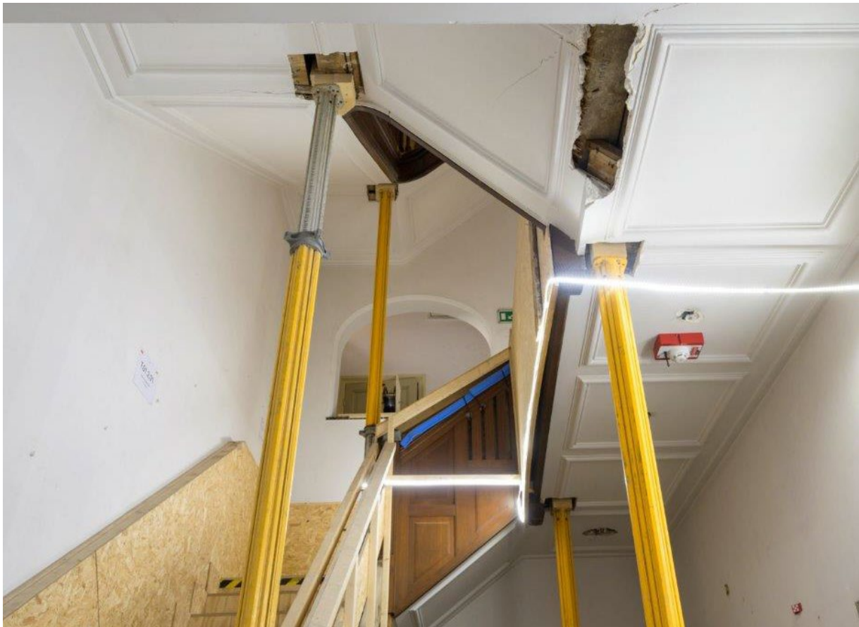
Tijdelijke hulpconstructie monumentaal trappenhuis Raad van State
