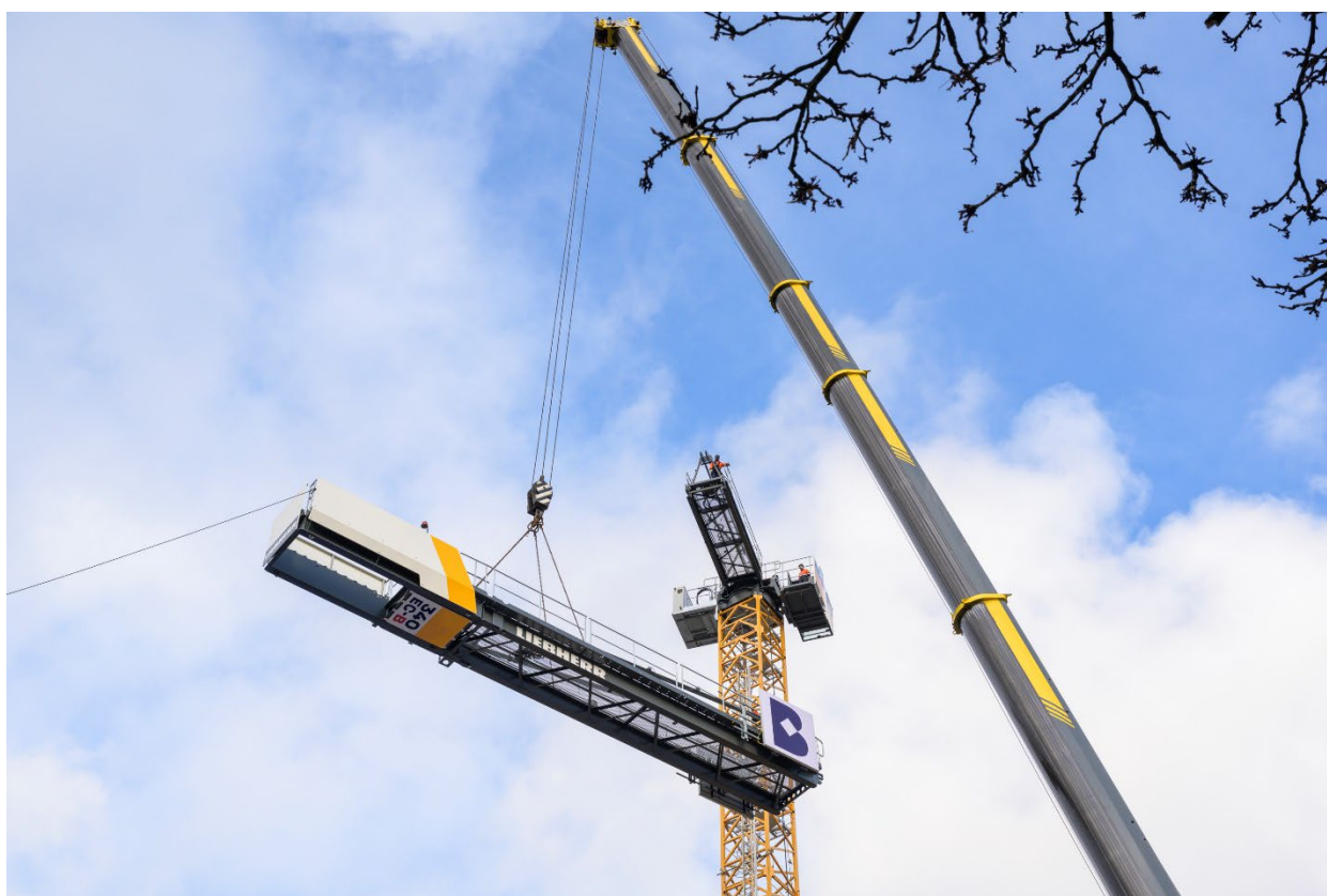
Installatie torenkraan
