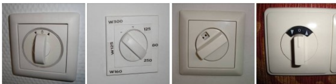
Figuur 13: Voorbeelden van bedieningsschakelaars die niet logisch zijn in gebruik. Bij deze schakelaars is het niet direct duidelijk in welke stand het ventilatiesysteem staat ingesteld en/of hoe het systeem in een hogere of lagere stand kan worden ingesteld.
