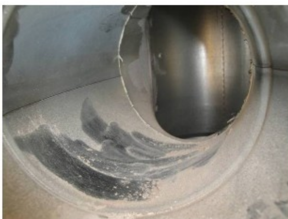
Figuur 18 (rechts): Voorbeeld van een luchttoevoerkanaal dat vervuild is door stof.
