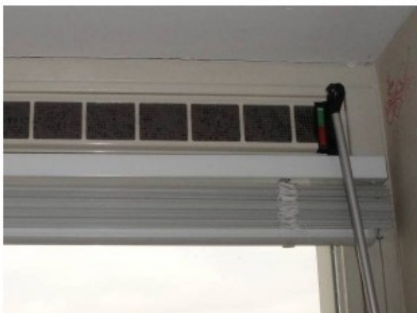
Figuur 15 (links): Voorbeeld van een vervuild gevelrooster.
