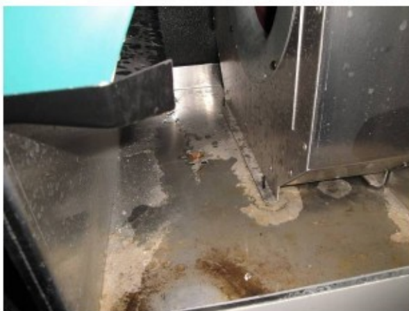
Figuur 19 (links): Voorbeeld van inwendige vervuiling (schimmel) in een ventilatie-unit met een kunststof behuizing.
