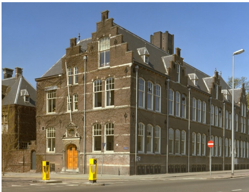
Het Sterrenbos-complex in Utrecht gezien vanaf de Catharijnesingel. Dit gebouw is gesloopt in 2005. De deur van dit gebouw is meegenomen naar Bilthoven en staat daar nog steeds. (Bron: beeldbank RIVM)
