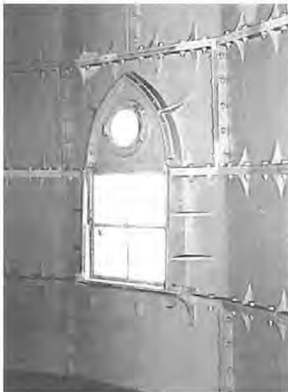
Verbindingssysteem wandelementen
