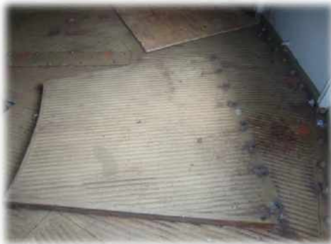
Vloerplaat 9A, uitgenomen
