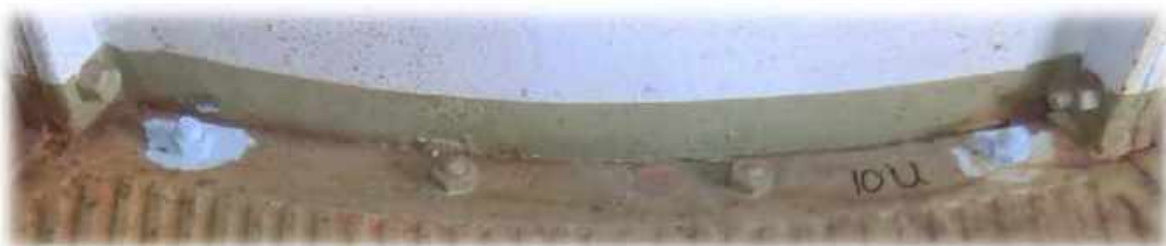
Status vloerplaat 10U op 21 juni 2011
