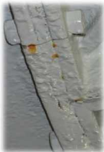
Ijzercement tussen de flenzen
