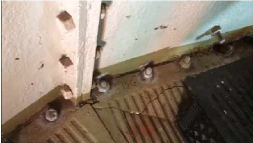
Figuur 6: bezwiken vloer op niveau 15 nabij transportroute
